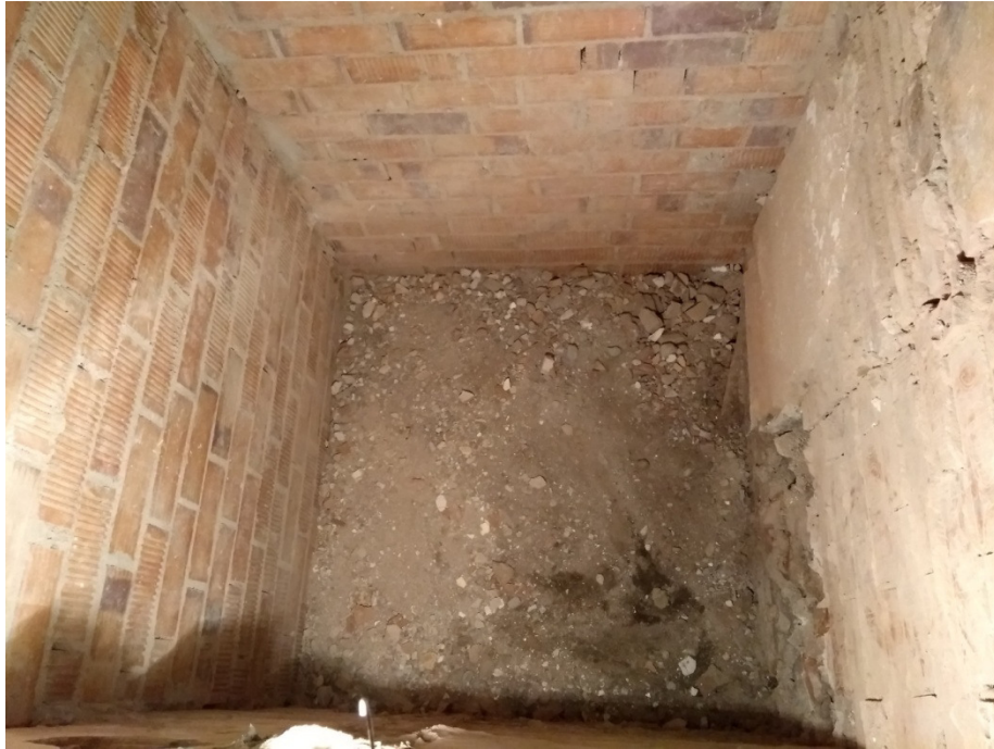
Imatge 2, vista del fossat un cop finalitzada la seva excavació.
