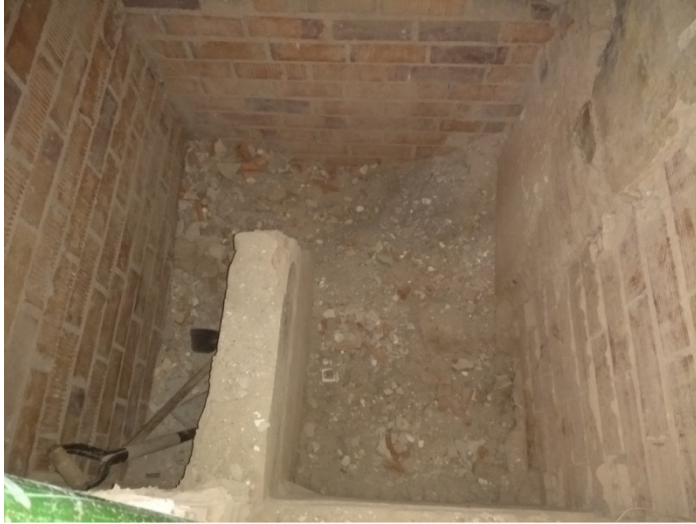
Imatge 1, vista del fossat abans de l'inici de la seva excavació.
