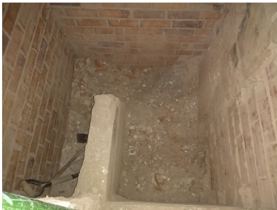
Imatge 1, vista del fossat abans de l'inici de la seva excavació.
